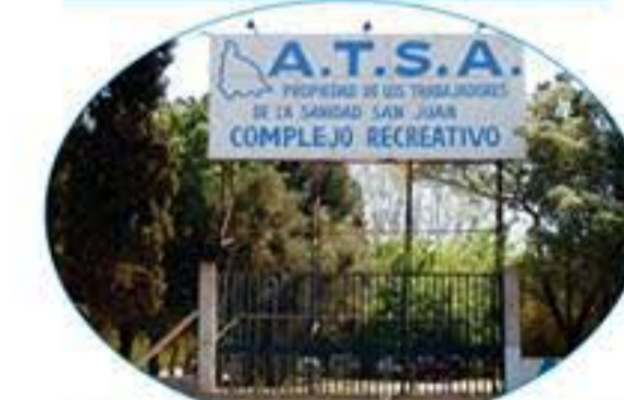
Camping de la Sanidad nuevas obras Playon deportivo, cierre perimetral, etc
