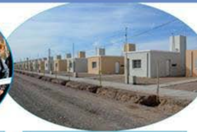
Construcción y entrega de 6 Barrios.
