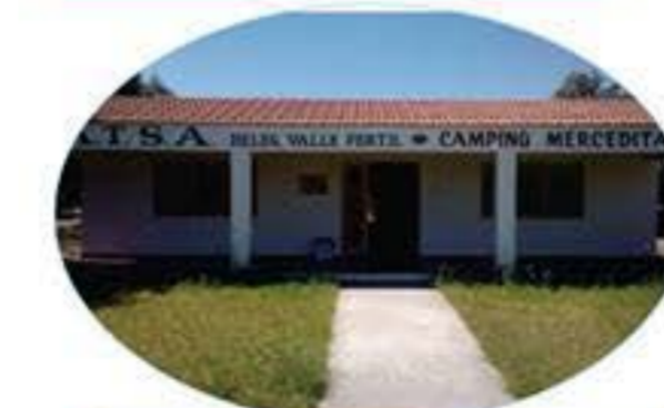
Finalizacion de las Obras en ntro. Camping de Valle Fertil
