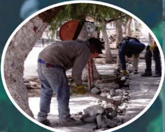
Obra de gasoducto
