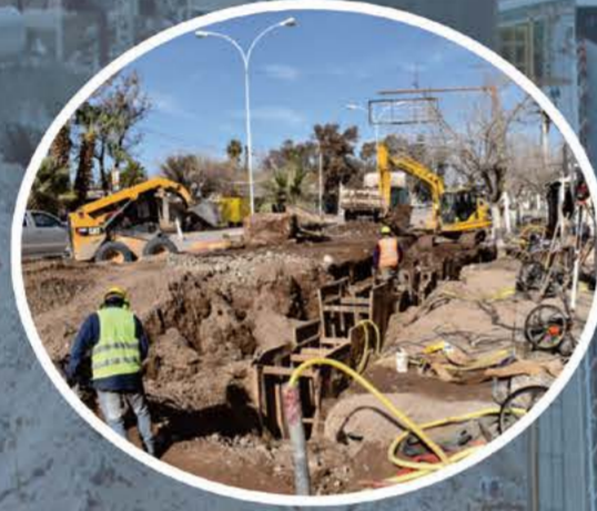
Obra de cloacas
