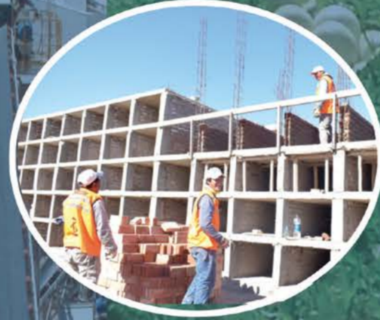
Ampliaciones de Cementerios
