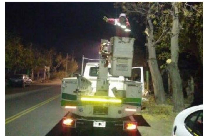
Se realizó poda de despeje de luminarias, se colocaron 19 brazos pescantes metálicos de 3 metros, 19 luminarias tipo paleta N° 52 con equipo auxiliar de 250w mercurio halogenado 19 lámparas de mercurio halogenadas de 250w, 680 metros de cable preensamblado de 2 X 16 mm para el cruce de línea eléctrica, morcetería, fusible y cableado. Dichos trabajos tienen como propósito el mejoramiento en la calidad de vida de los vecinos, como así también brindar mayor seguridad a los transeúntes.
