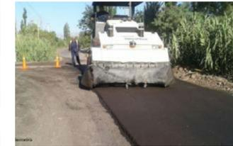
Estas labores de concreto asfáltico en caliente para conservación y mejoramiento de la Red Vial Provincial incluyen 1260 metros de calle 6 (RP 159) en dos secciones. La primera comprendida entre las calles Lemos y Vidart donde se ejecutó la capeta de rodamiento con un espesor de 5cm de concreto asfáltico. La segunda contempla 1346 metros de dicha ruta provincial en el tramo que
