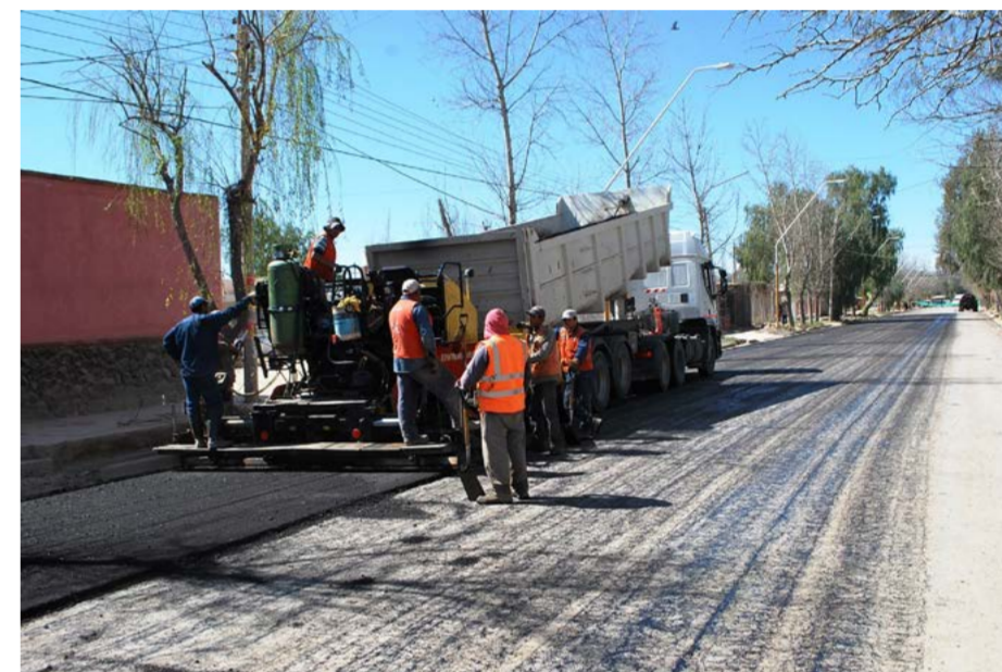
ASFALTO EN 25 DE MAYO
