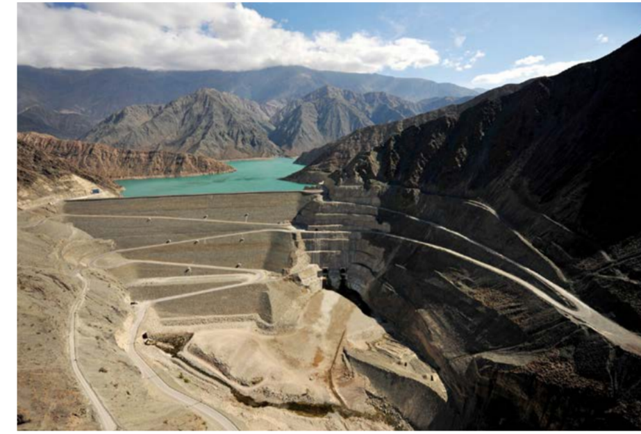
Dique Punta Negra
