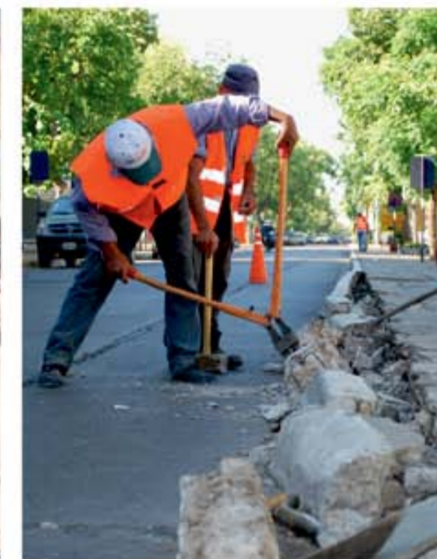
ARREGLO CORDON: Calle Alem, cortando hierro.
