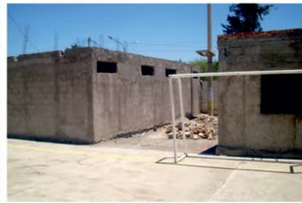
Más obras. Las oficinas del Polideportivo están en plena ejecución.
