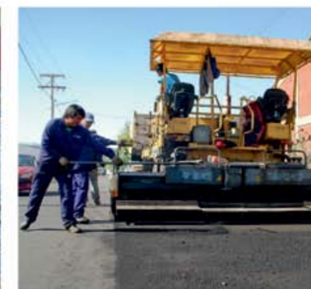
PAVIMENTO ADYACENCIA TOYOTA: máquina, operarios, pavimento
