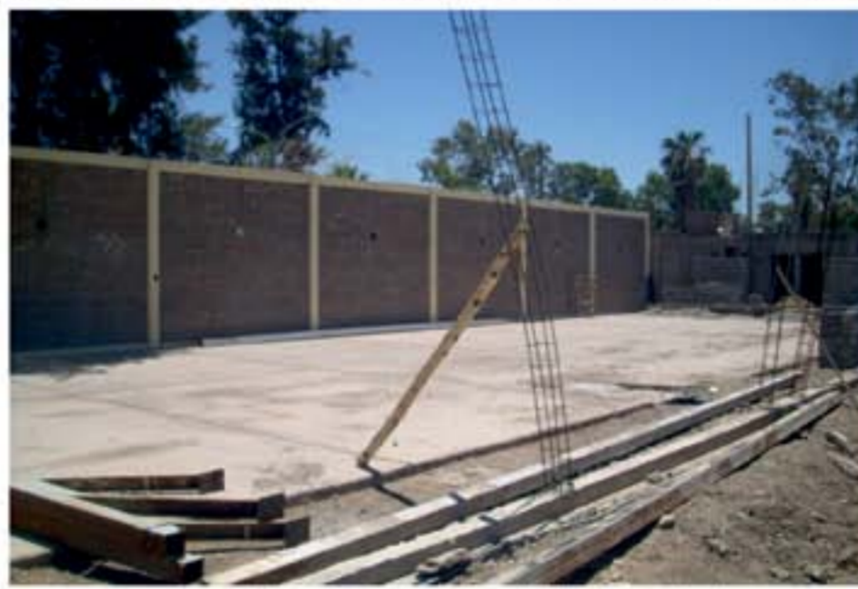
En marcha. Avanzan las obras para mejorar el Polideportivo municipal.
