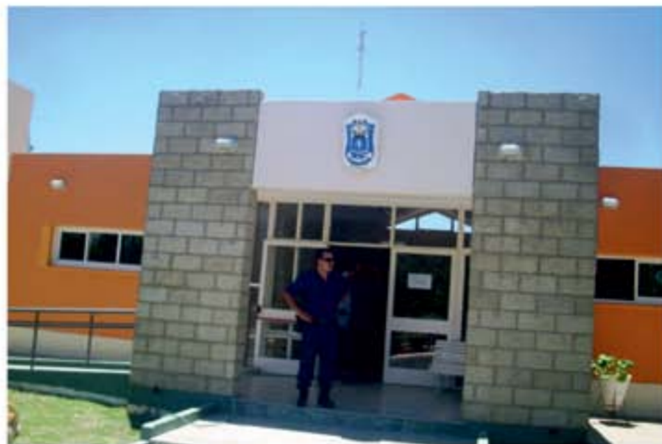
La nueva seccional policial, inaugurada hace tres meses posee modernas instalaciones.
