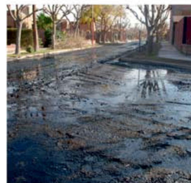
B° SOLARES IV. Asfalto
