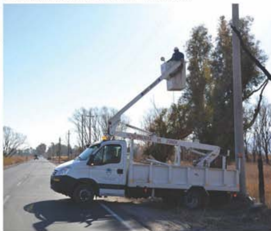
Serán 1500 metros de nueva iluminación en calle Las Moras.
