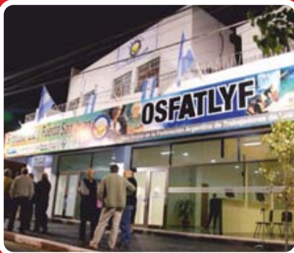
Las nuevas instalaciones del Sindicato y la Obra Social OSFATLYF, ubicado sobre calle 9 de Julio en Capital, totalmente renovadas.
