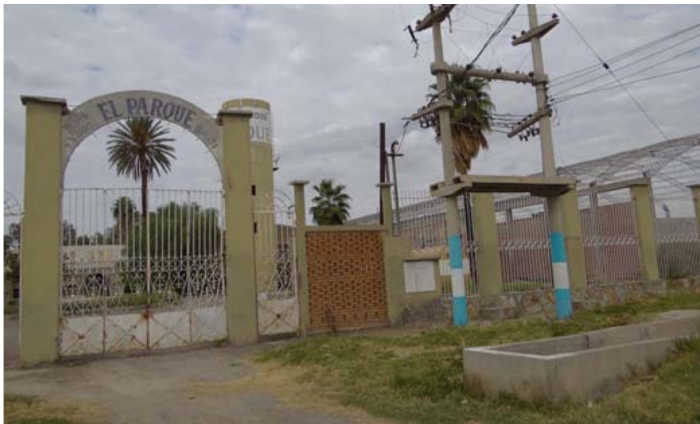
Las instalaciones de la ex bodega El Parque, sujetas a obras de remodelación.
