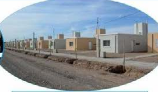
Construcción y entrega de 6 Barrios.
