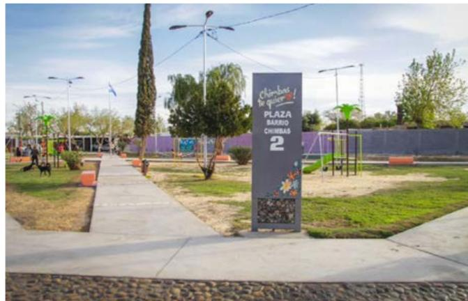
En el gran espacio verde se construyeron veredas de hormigón alisado, cordón zapata y se colocó piedra bola como detalle en las ochavas.
