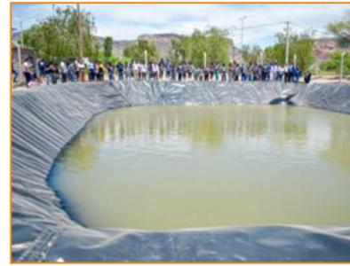
dad arcillosa de 10 cm y posterior impermeabilización con geomembrana de 750 mm, soldada y anclada. Se hicieron,
