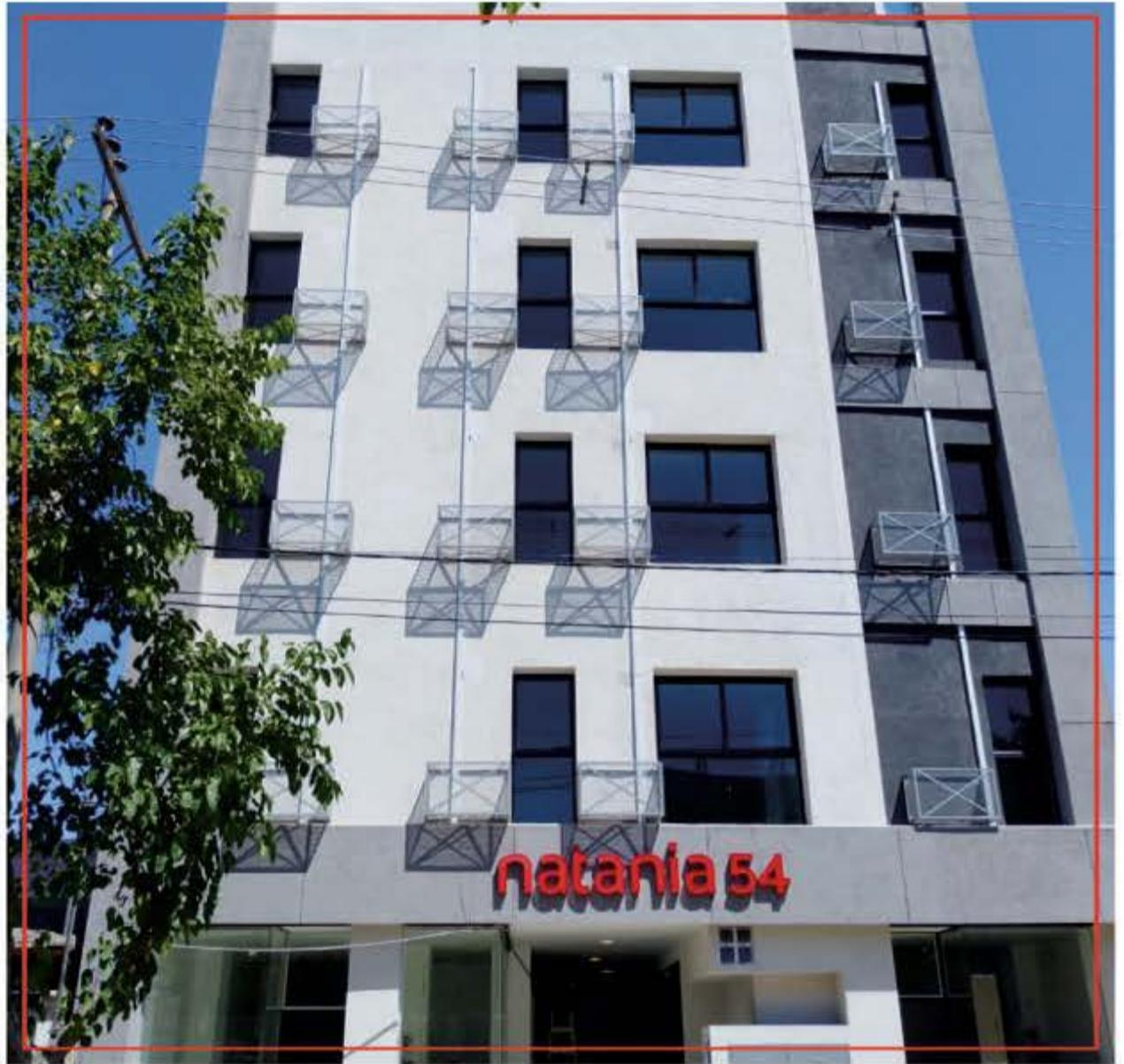
ESTIMADA: 2023. ESTADO: en obra. AVANCE DE OBRA: 51%. TAREAS EN CURSO: Ya terminamos la estructura de hormigón armado y la instalación de gas de la Torre I. Comenzamos con los revoques interiores y pronto iniciaremos la colocación de pisos. COMPOSICIÓN: Este emprendimiento tendrá 85 departamentos de 1 y 2 dormitorios, además de 22 cocheras y 5 salones comerciales.
