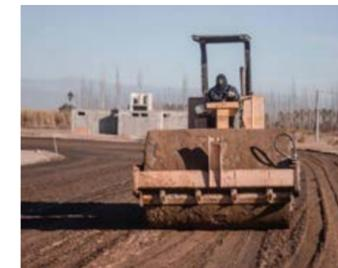
"Llevamos a cabo tareas de construcción del paquete estructural con material clasificado previo a la pavimentación y los trabajos de drenaje interior
