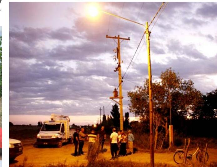
La obra consistió en la colocación de 32 artefactos de 150 watts, con sus respectivos brazos pescantes, juegos de zócalos y foto control para su encendido automático. Estas luminarias, fueron colocadas de manera puntual, frente a cada vivienda de los vecinos de la zona.
