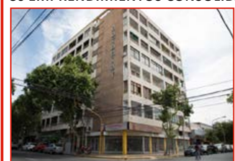
Natania 1, edificio en calle Santa Fé.
