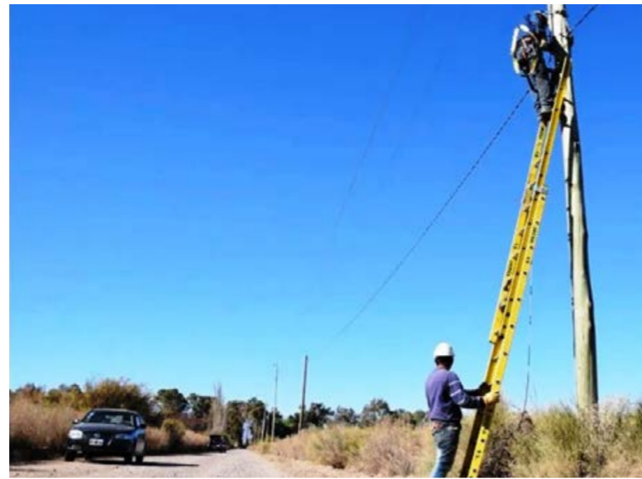
además se mejora un tramo clave de la calle que conecta el departamento al acceso a Albardón, brindando más seguridad.
